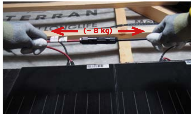
WICHTIG! Nach dem Verknüpfen der Stecker – wie im Bild dargestellt – muss die ordnungsgemäße Verbindung durch Auseinanderziehen überprüft werden!
