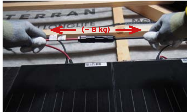
FONTOS! A csatlakozók összedugaszolását követően – a képen látható módon – szét húzással ellenőrizni kell a megfelelő csatlakozást!
